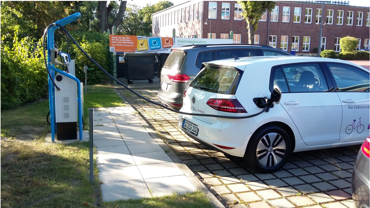
Abbildung 24: Kabel an den Ladesäulen recht kurz (Ladesäule an der Ostfalia in Salzgitter)
