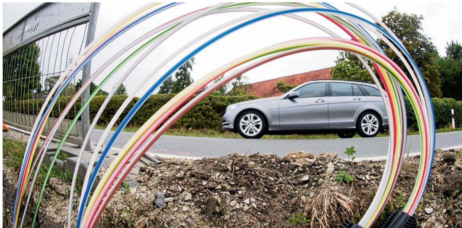
Ein Auto fährt an einer Baugrube vorbei, in der Leerrohre für Glasfaserleitungen für schnelles Internet liegen.
